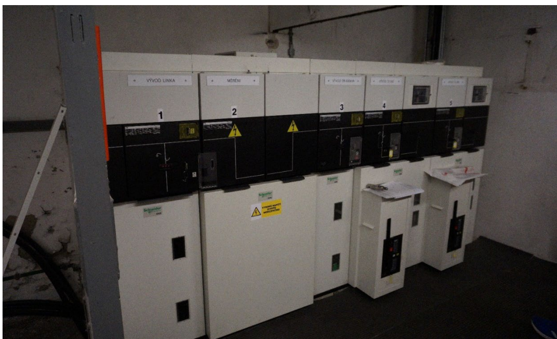
Obrázek 2 – Stávající rozvodna VN (Vysokonapěťová podélná spojka)
