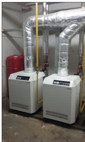
Obrázek 2: Plynová kotelna
