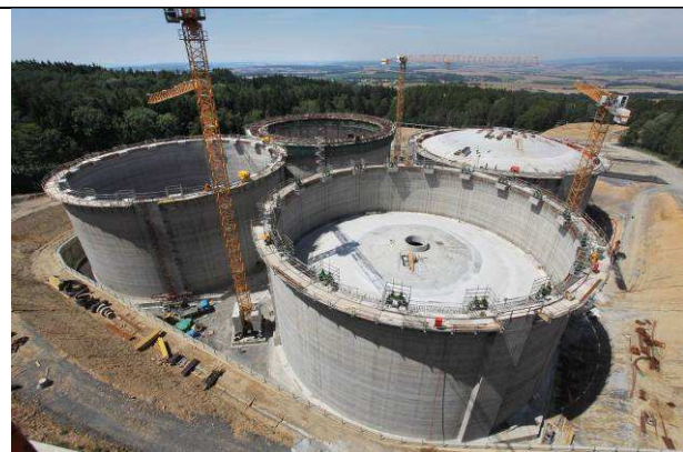
Obr. 7 Pohled na stavbu čtyř nádrží v Loukově
