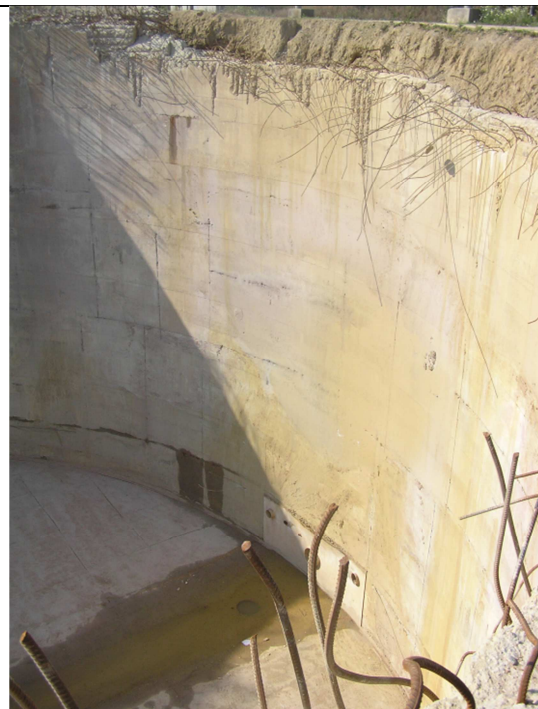
Obr. 1 Pohled do nádrže, viditelné řezy
