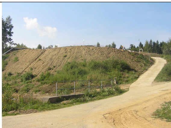
Obr. 6 Pohled do nádrže – příjezd a svahy
