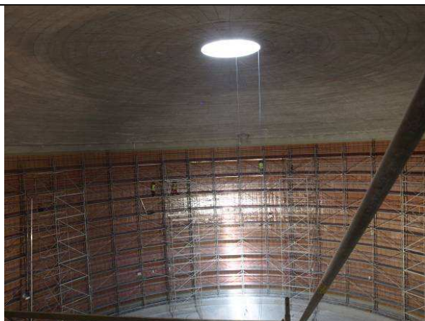
Obr. 8 Pohled do nádrží v Loukově, provádění vystýlky
