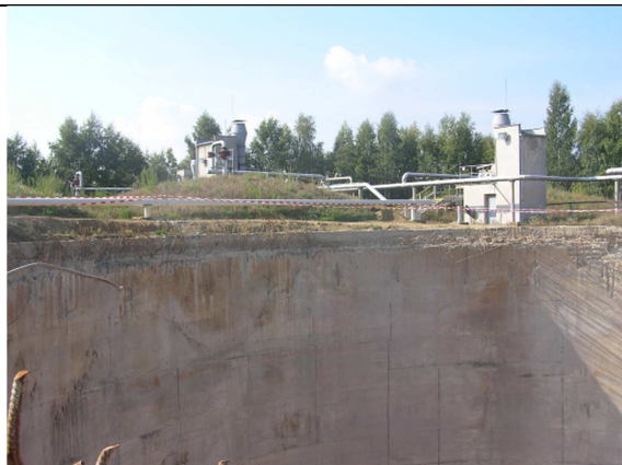
Obr. 4 Pohled do nádrže – horní líc stěn
