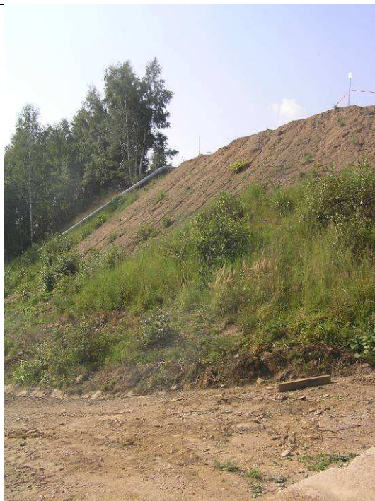
Obr. 2 Pohled na násyp nádrží
