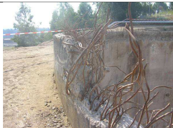
Obr. 5 Pohled do nádrže – kotvení střechy
