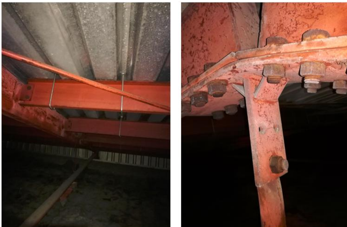
Pohled na kotvení vaznic k vazníku (vlevo) a spoj horní pásnice vazníku v hřebeni (vpravo)
