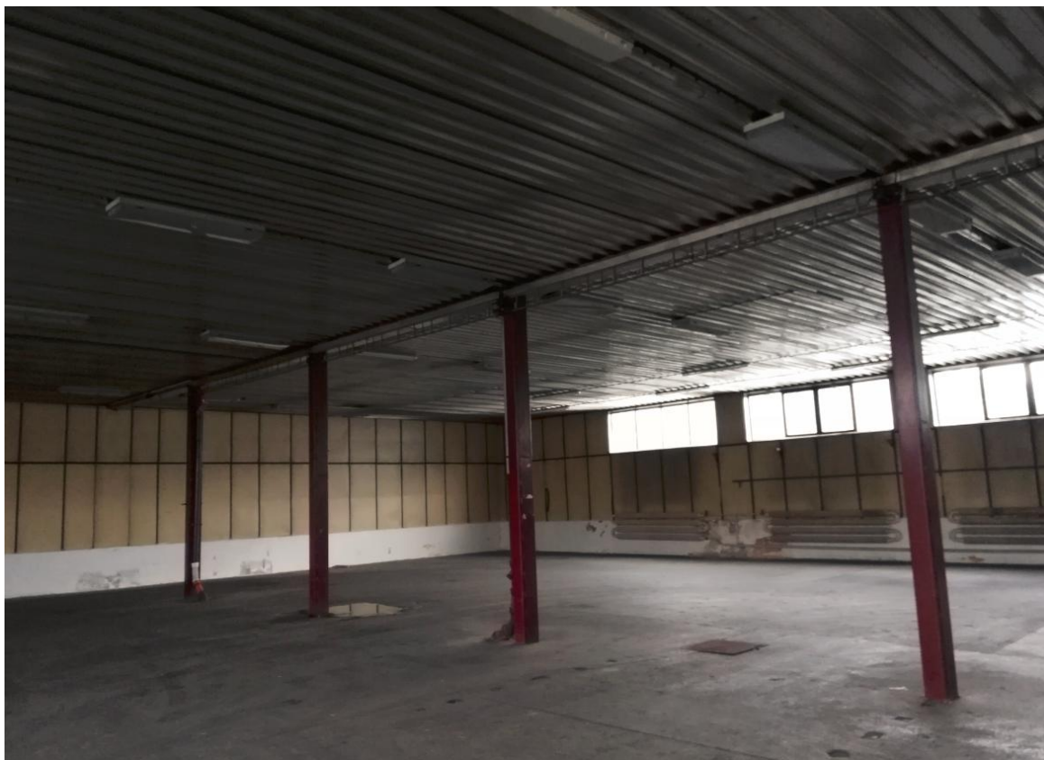
pohled na podhled zakrývající nosnou konstrukci střechy
