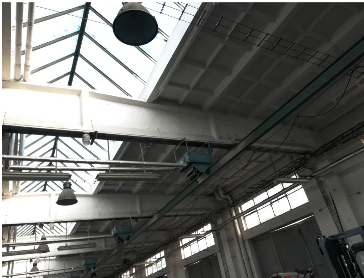
pohled zevnitř haly na kazetové panely, vazníky a sloupy
