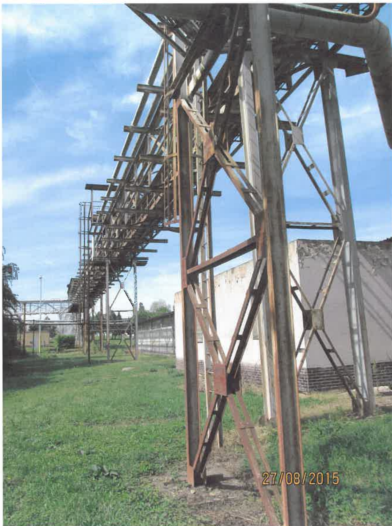
Průběh potrubního mostu – místo ohybu : směr k lokoreміze
