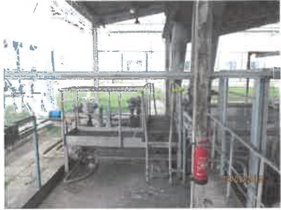
Obj. 223- přístřešek u filtrů
