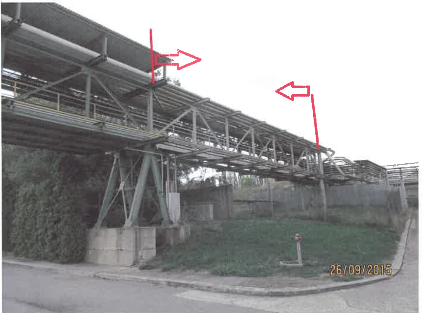
Nátěr potr. Mostu- nátěr vymezeného úseku u admin. budovy
