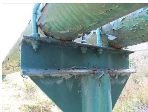
Obr. č. 2: Upevnění potrubí třmeny
