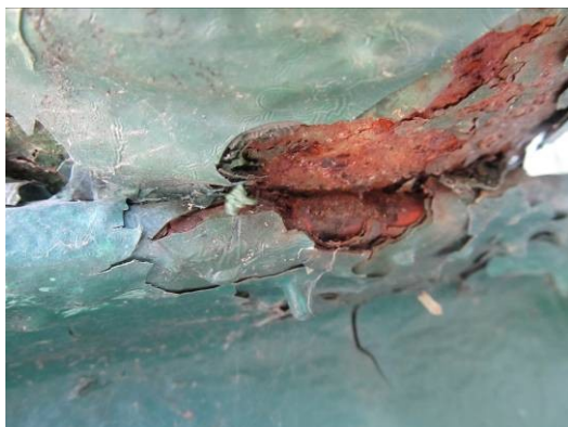
Obr. č. 1: Styk potrubí a podpěr
