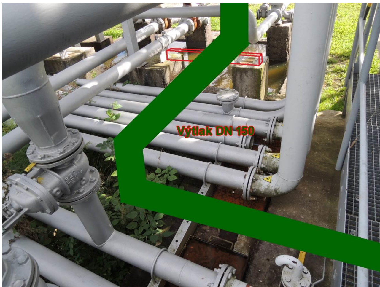
Nová trasa výtlačného potrubí DN 150.
