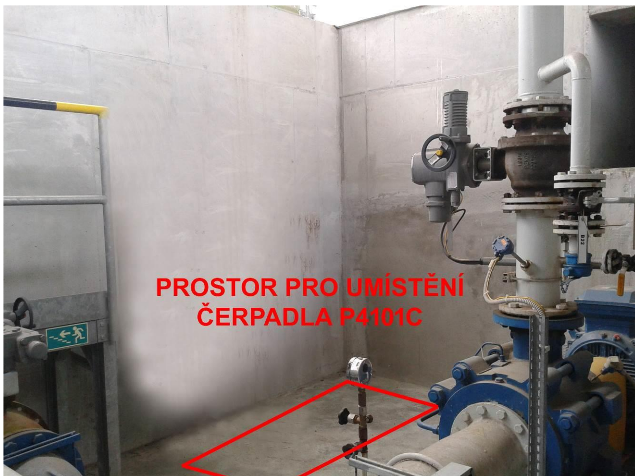
Navrhované umístění čerpadla P4101C v čerpací stanici 230.
