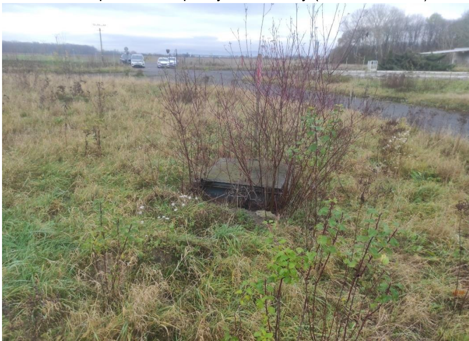
Kanalizace v pleše, záhon pro vybrání zeminy (kontrolní šachta)
