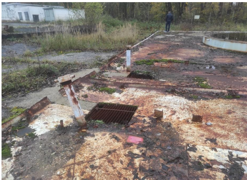
Dešťová kanalizace včetně odvětrání
