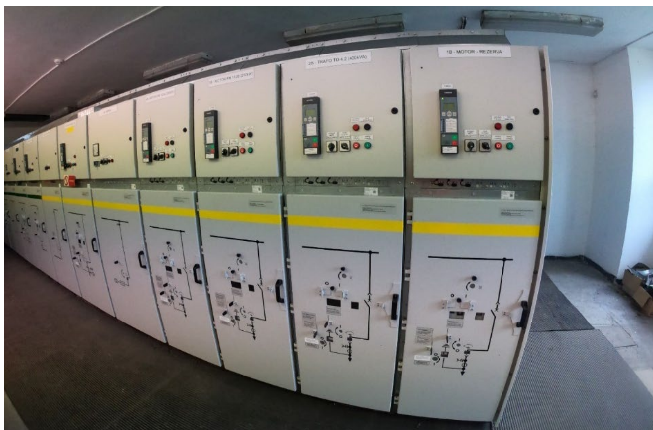
Obrázek 2 – Stávající rozvodna VN (Vysokonapěťová podélná spojka)
